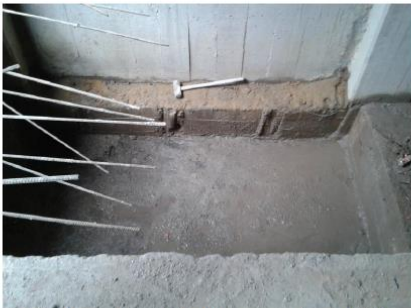
Foto 5. Pozo 2 con lodo - 12 de noviembre de 2013.
